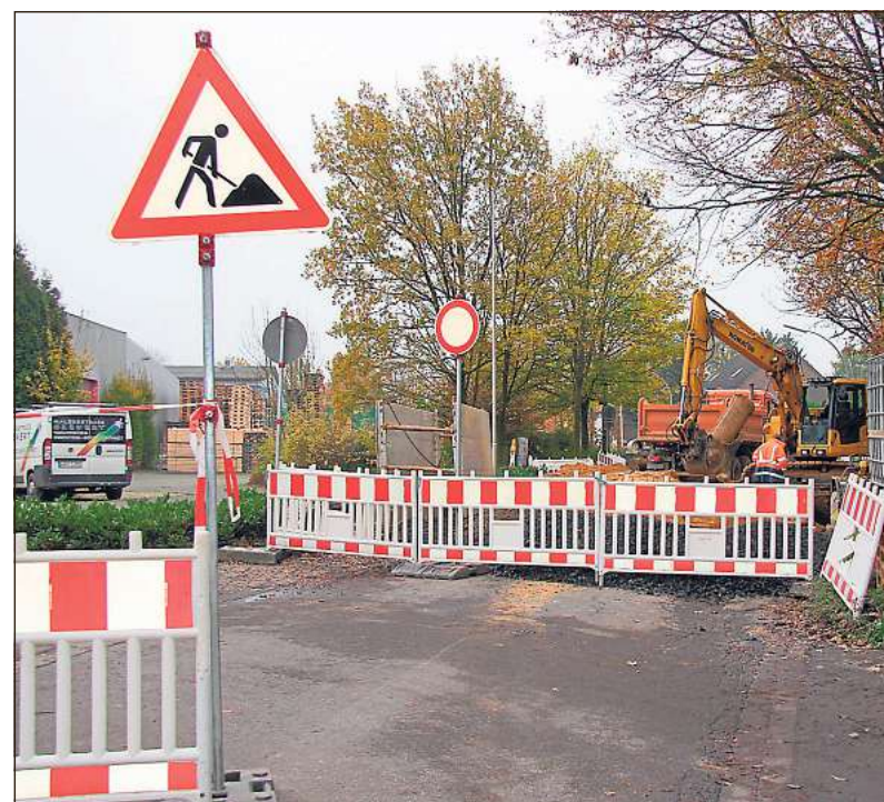
Wegen des Baus des Regenwasserkanals ist die Eisenbahnstraße in Freckenhorst bis Anfang 2018 gesperrt. Bild: Kleigrewe
