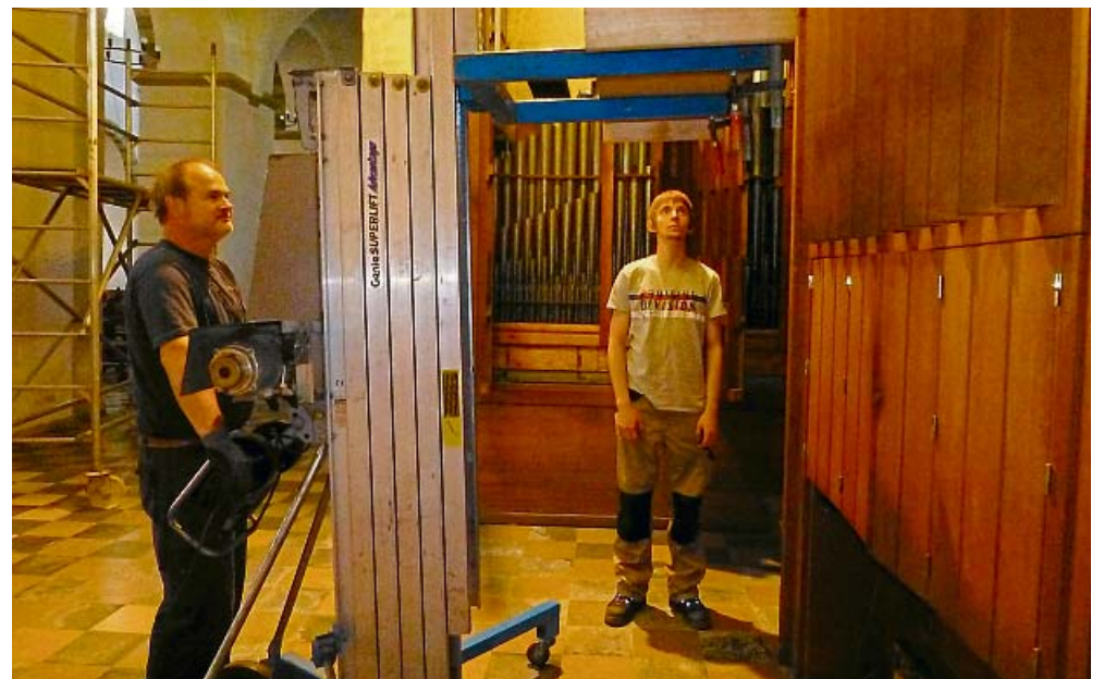
Mitarbeiter der Orgelbauwerkstatt Seifert aus Kevelaer haben gestern in St. Bonifatius mit dem Abbau der renovierungsbedürftigen Orgel begonnen.
