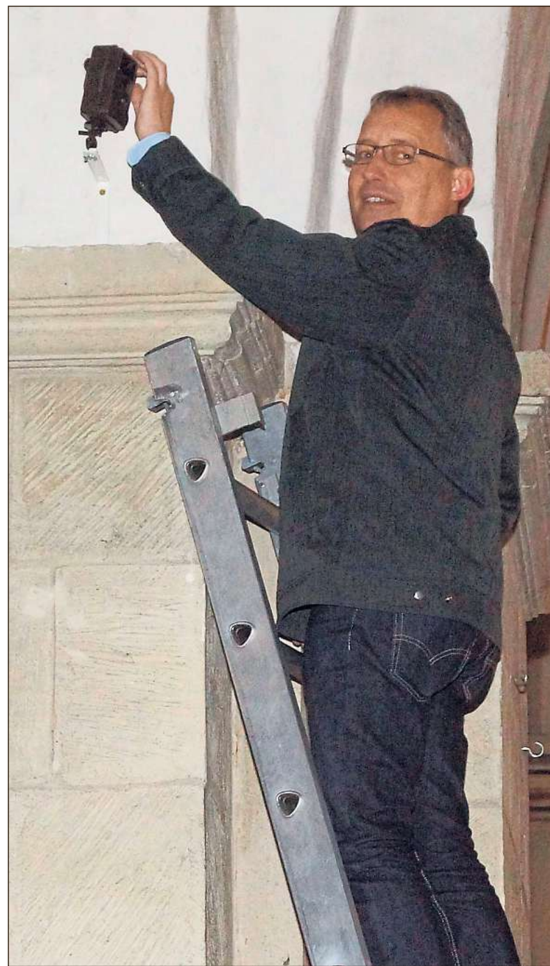
Rund fünf Meter hoch muss Michael Kraß einmal in der Woche auf der Leiter steigen, um den Speicherchip der im Altarraum angebrachten Kamera auszutauschen. Seit Ende vergangenen Jahres läuft die Dokumentation der Sanierungsarbeiten. Bilder: Baumjohann
